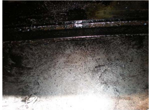
Grindis po cisternos išleidimo
